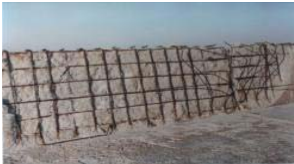
شکل ۲- لایه لایه شدن کل کاور یک دیواره موج شکن، منبع: (Danish hydraulic Institue (۱۹۸۶)
